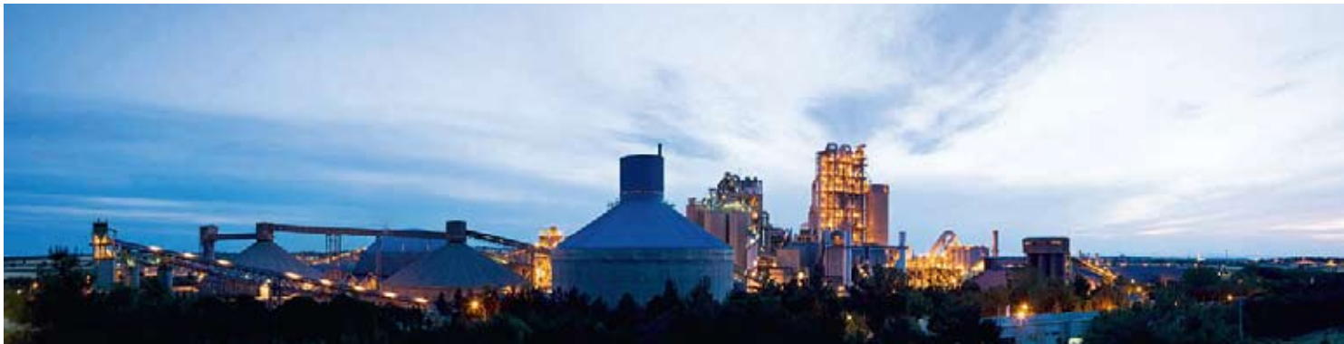
中国建材承建的土耳其日产6000吨新型干法水泥熟料生产线
