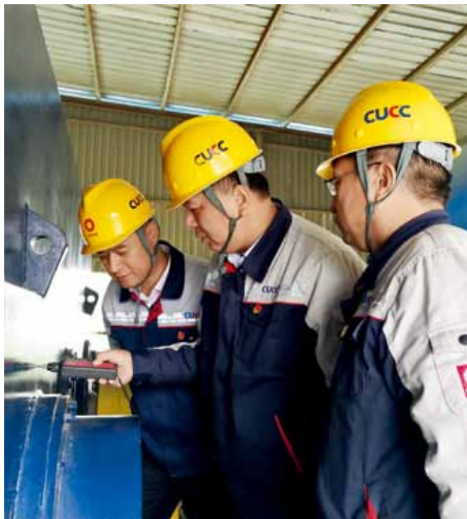
对设备进行巡检
