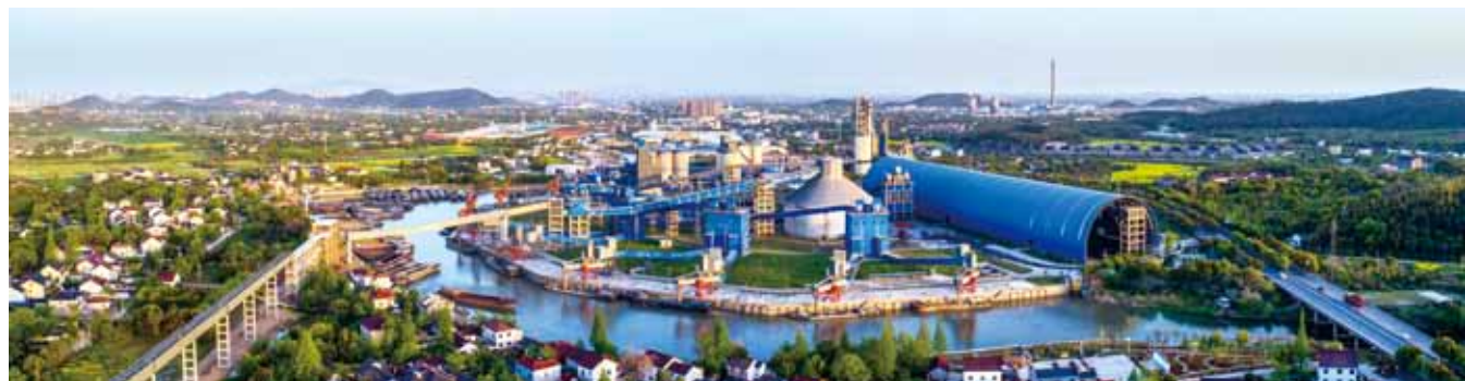
南方水泥全封闭无污染物流传送带——跨长湖申运河接口段
