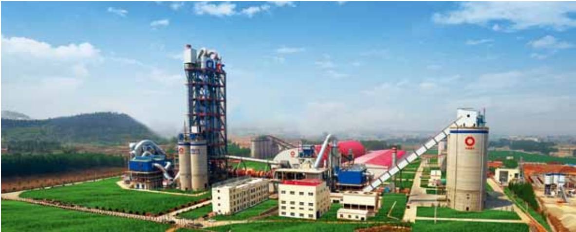
中国建材在山东泰安自主建设工业4.0智能化水泥生产线，被誉为“世界水泥的梦工厂”
