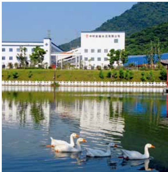
中材安徽水泥循环产业园协同处置生活垃圾项目
