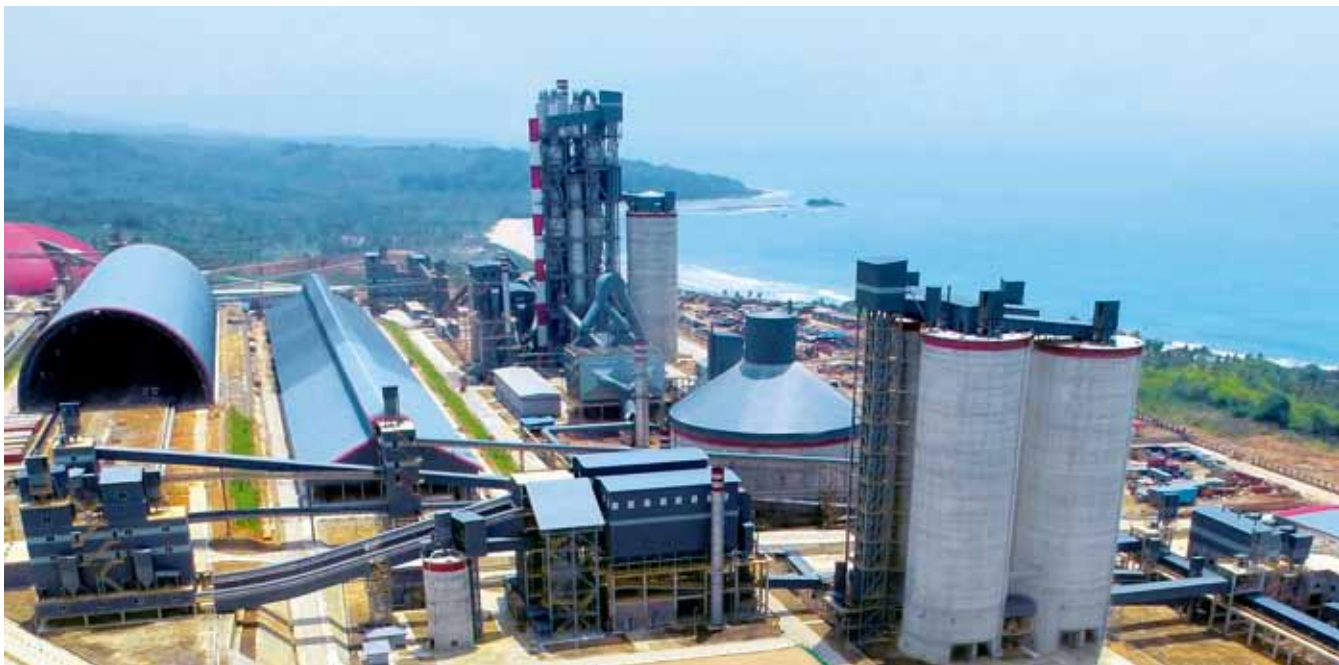
生产线结构紧凑, 布局合理
