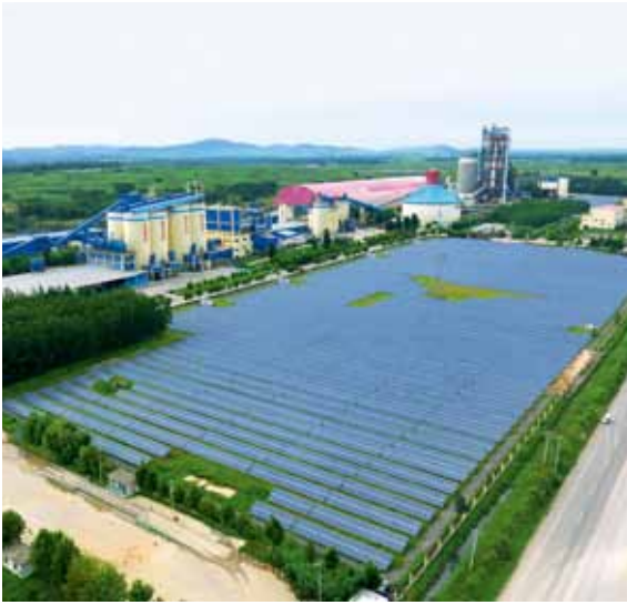
中国建材依托自身新能源技术和材料优势，将水泥厂打造为新能源工厂
