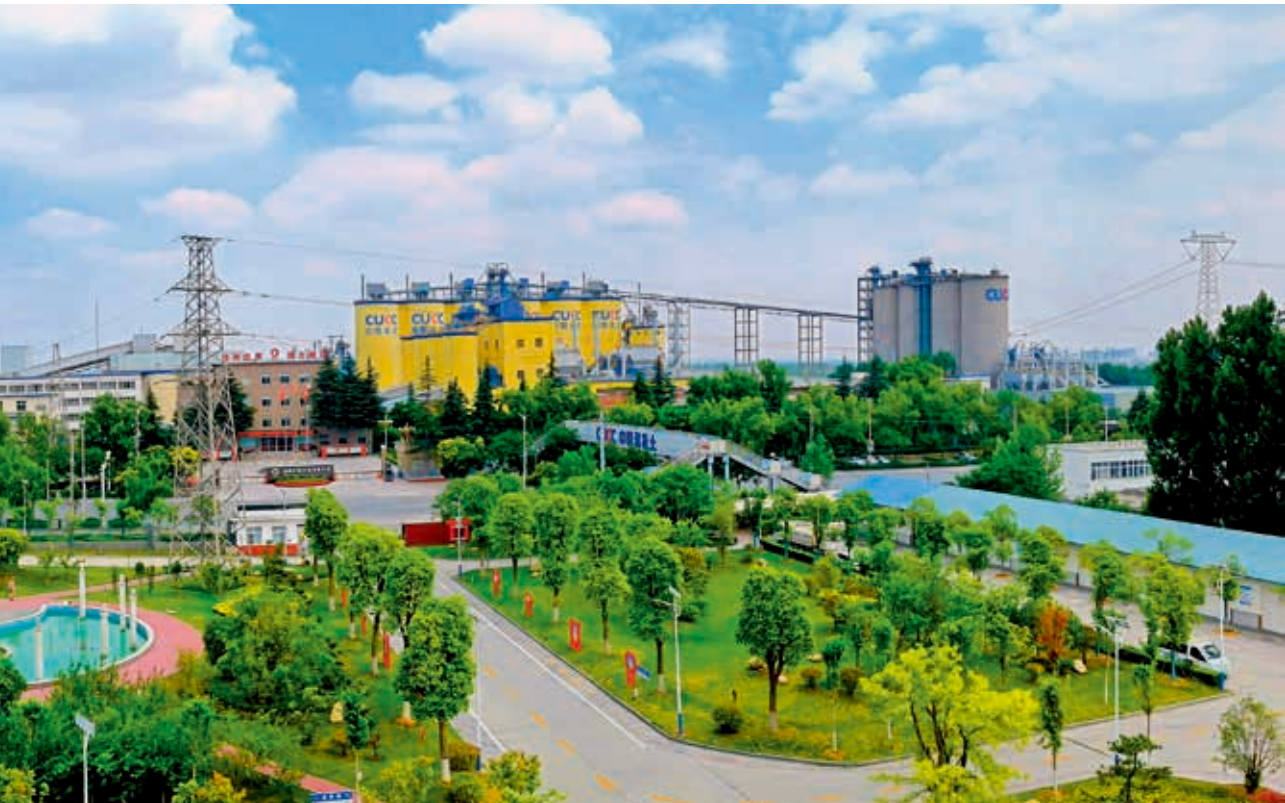
南阳中联厂区
